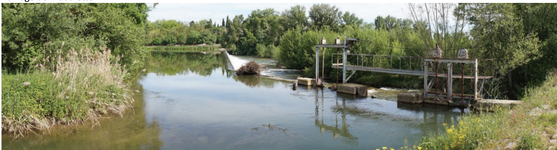
Barrage du Païcherou
