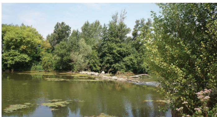
Barrage sur Aude
