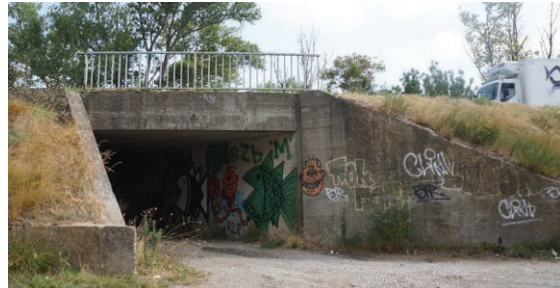
Passage en sous oeuvre : continuité en rive d'Aude
