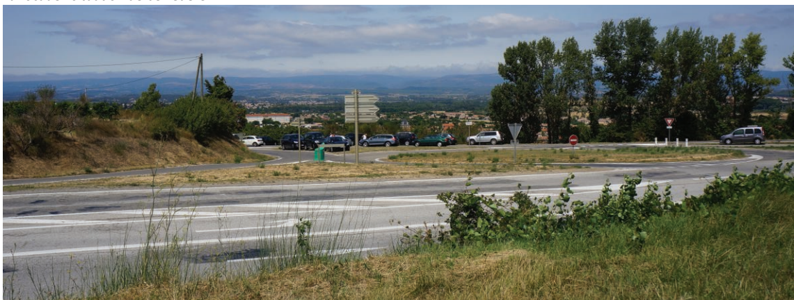
Les carrefours : des espaces utilisés comme aires de stationnement et «drive view»
