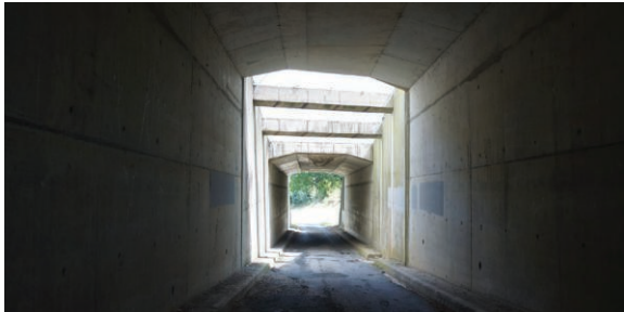
Passage en sous oeuvre : A61
