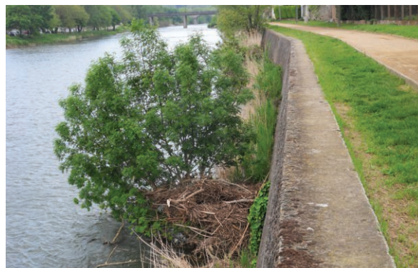
Berge minérale mais avec une risberme colonisée par de la végétation (entre le pont vieux et le pont de l'avenir en rive droite)
