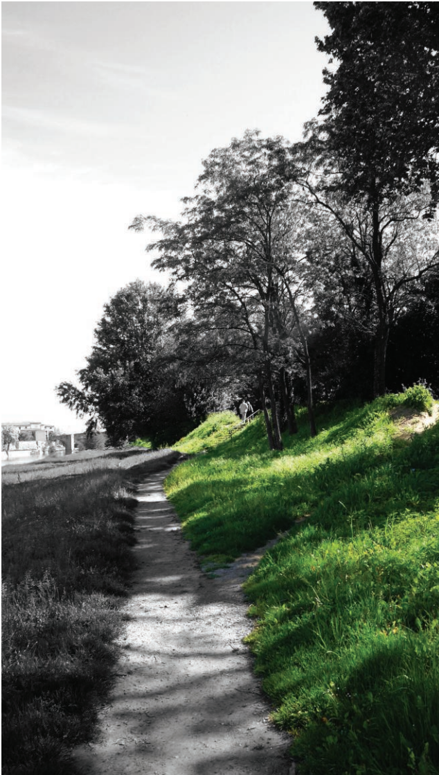
La digue de l'Aude
