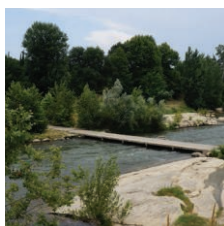
L'entrée du passage à gué
