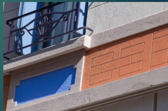
Façade art déco aux étages sur un soubassement à bossages réalisé au mortier vers 1910.
