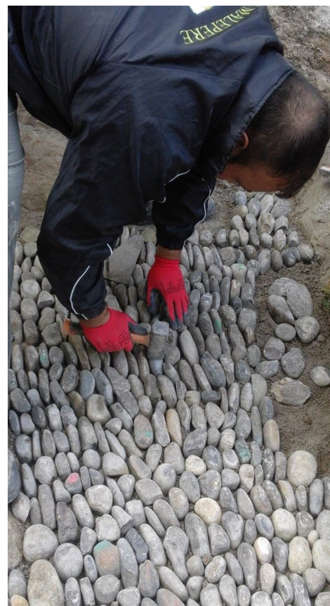
Mise en œuvre et coordination du chantier engagé sur la réfection de la montée de la petite côte. Résultat : deux mois de chantier et réfection des calades de la montée de la petite côte.
