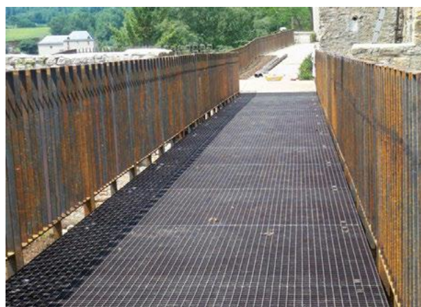
Aménagement du Chemin de l'école Puys Leveque (46)
