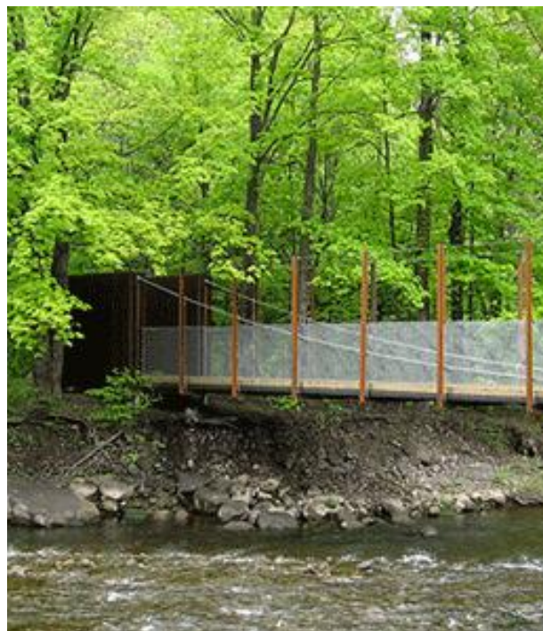
Aménagement d'une passerelle piétonne- Pincourt- Québec
