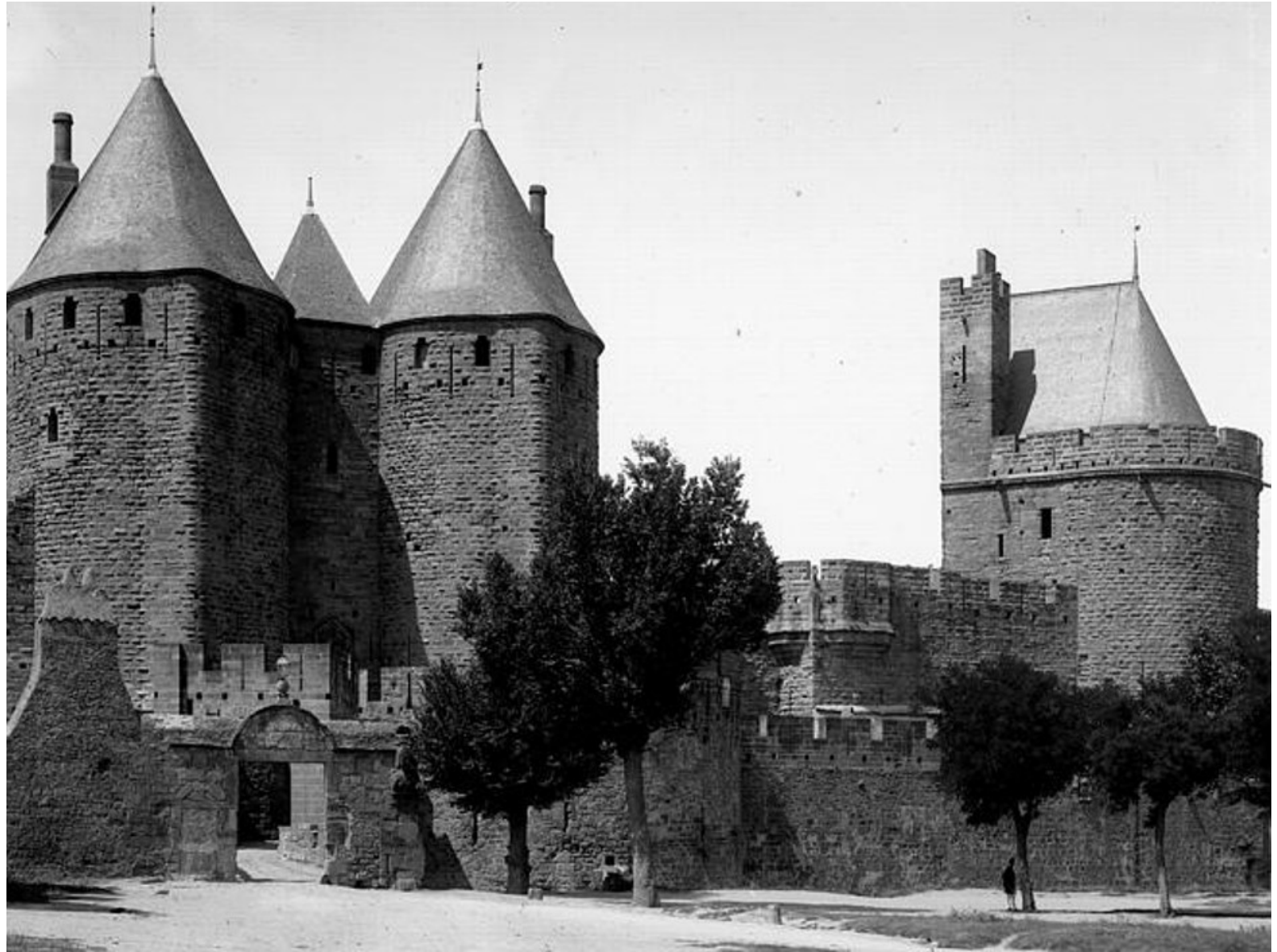
PHOTOGRAPHIE ANCIENNE (1900), MONTRANT UN SOL CONTINU ENTRE LE PLACE DU PRADO ET SON JARDIN
