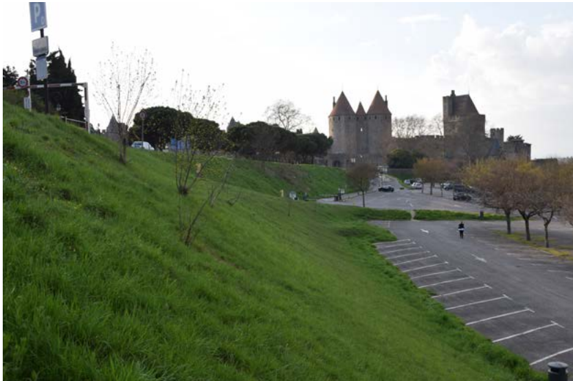
VUE DU TALUS SÉPARANT LE CHEMIN DE MONTLEGUN ET LE PARKING DELTEIL
