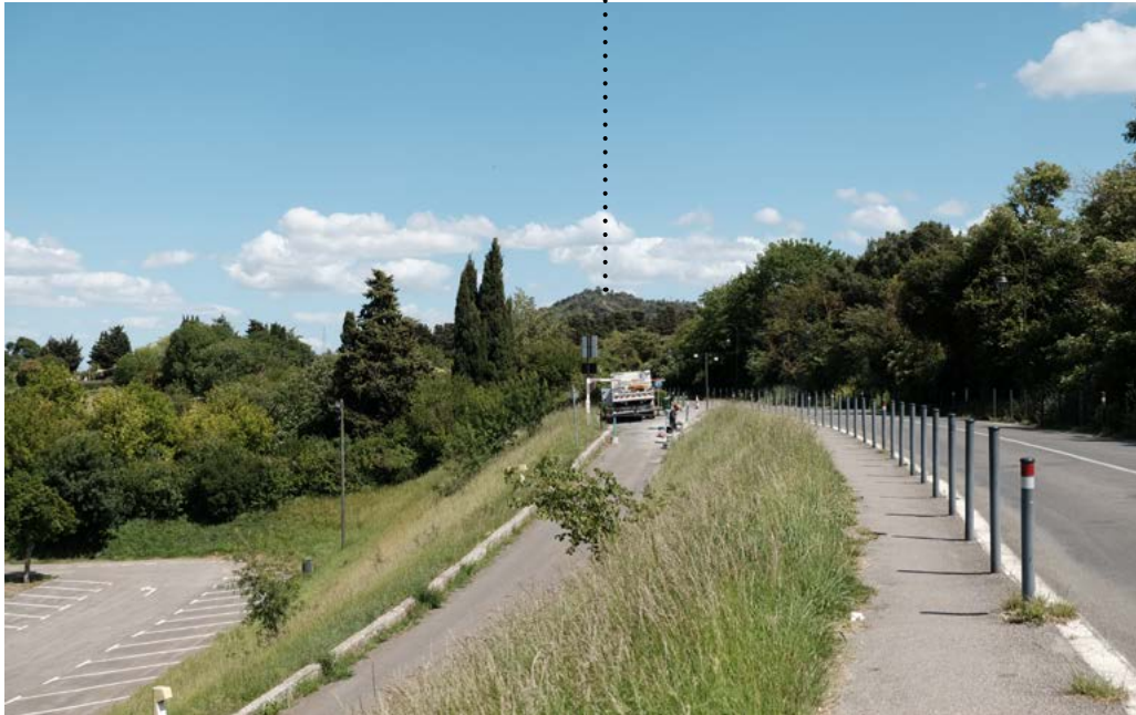
VUE AU NIVEAU DU PARKING DELTEIL
